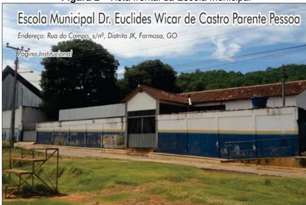
Figura 2 - Vista frontal da Escola Municipal
