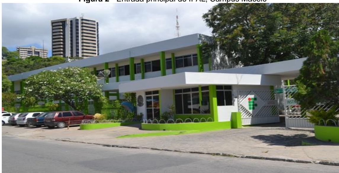
Figura 2 - Entrada principal do IFAL, Campus Maceió
